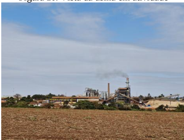
Figura 20. Vista da usina em atividade
