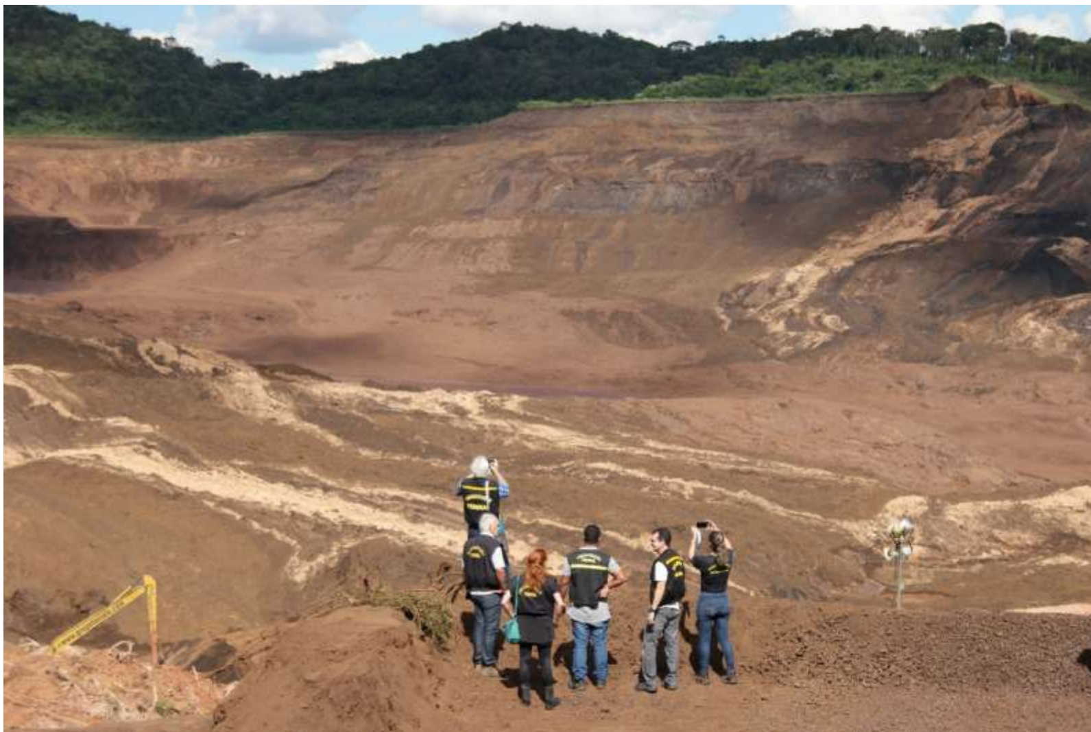
Barragem 1 da Minas Córrego do Feijão após o rompimento (Foto de 28/01/2019. Fonte: Auditoria Fiscal do Trabalho)
