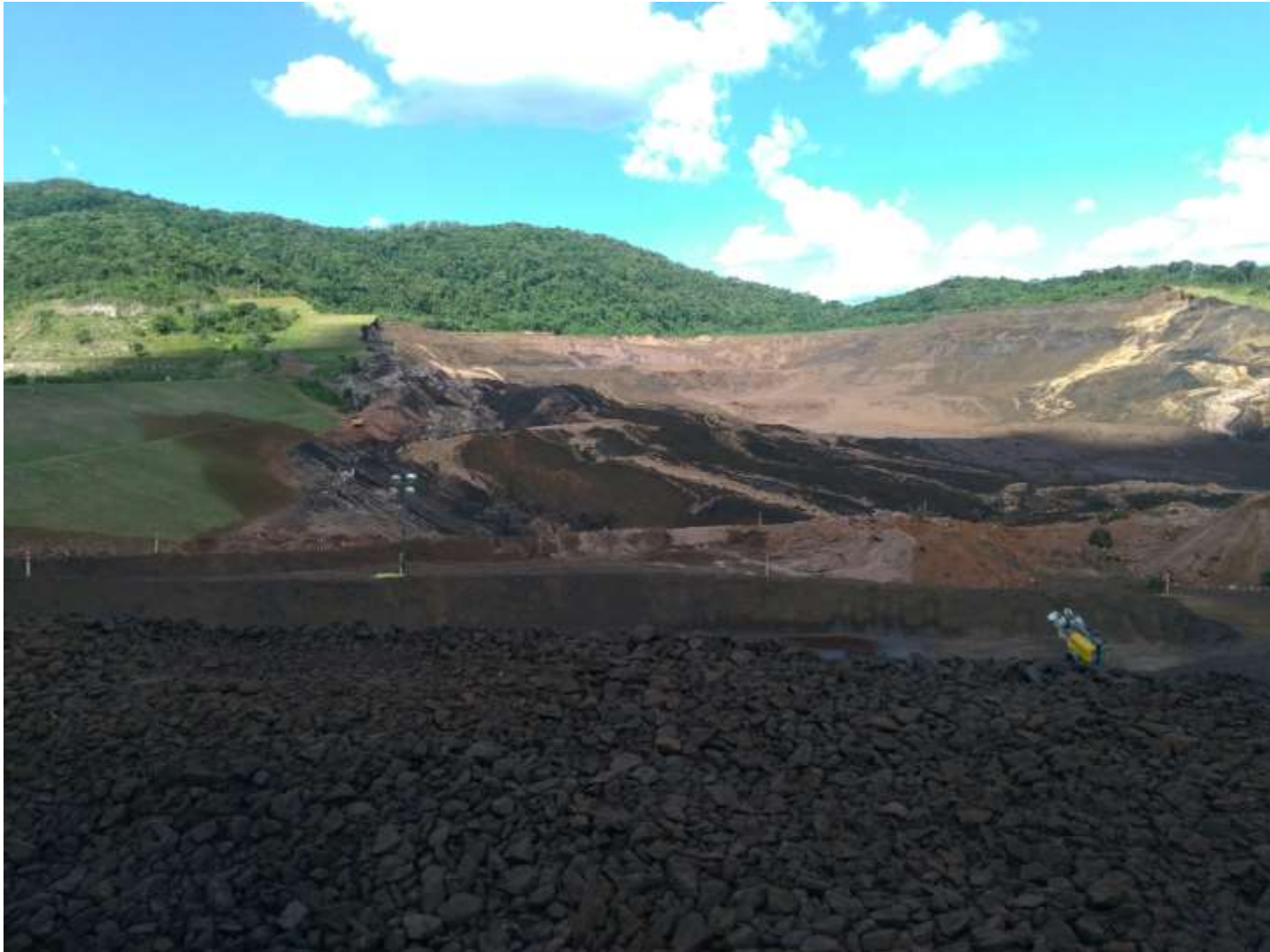
Barragem 1 da Minas Córrego do Feijão após o rompimento (Foto de 28/01/2019. Fonte: Mário Parreiras de Faria)
