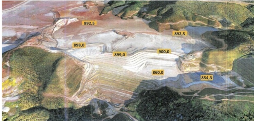
Figura 2: Vista geral da BRF pré-rompimento.
