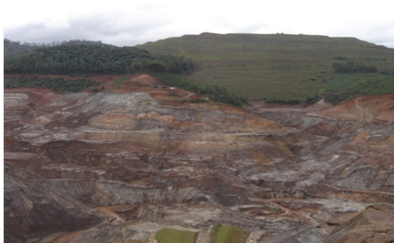
Figura 3: BRF após o rompimento em 01/12/2015 – vista do encaixe das ombreiras direita (na parte inferior da foto) e esquerda (na parte de cima da foto).
