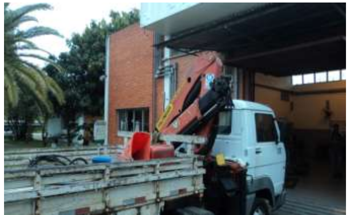
Vista geral do equipamento improvisado, utilizado para o acesso vertical de pessoas.
